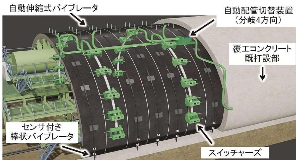
戸田建設らは、山岳トンネルの覆工コンクリートを自動打設するロボット「セントルフューチャーズ」を開発した。コンクリ打設口を自在に切り替える装置「スイッチャーズ」や各種センサー、締め固め機械などを組み合わせてセントル（移動式鋼製型枠）に配備。打ち込みから締め固めまで一連の打設作業を初めて自動化した。覆工コンクリ打設作業の効率化や省人化を実現する。
