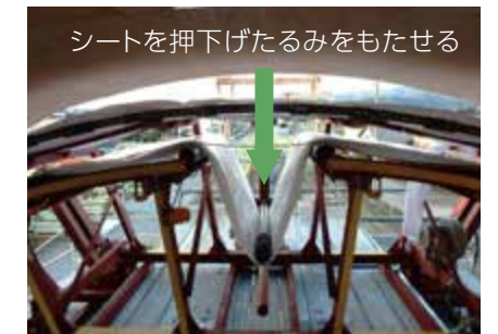
写真-3 押下げ機工装置の全景
