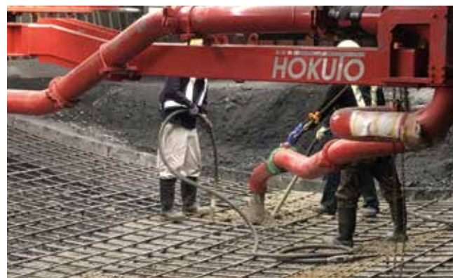
インバートコンクリート用ディストリビューター
