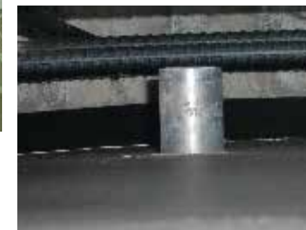
バイブレーターが突き出した状況
