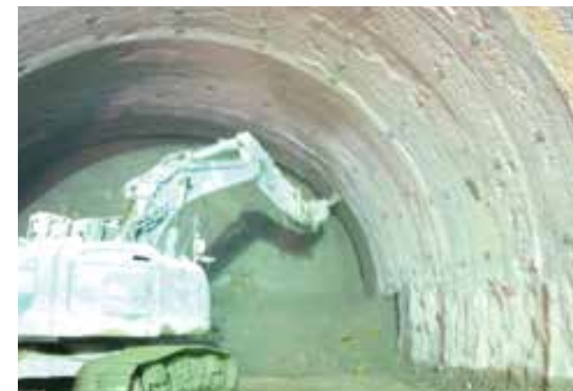
スクレーパーで平滑作業中
