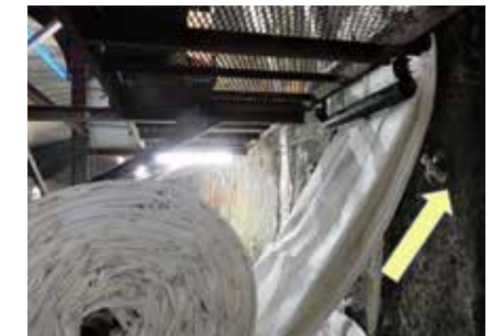
写真-2 蛇腹シートの牽引状況
