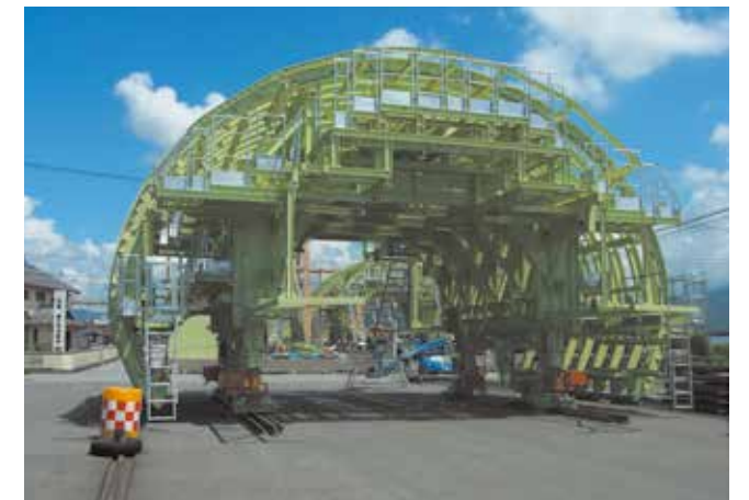
非常駐車帯用スライドセントル
