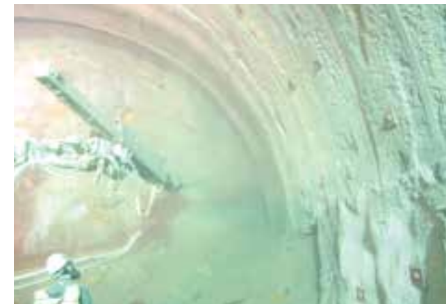
吹付け作業中
