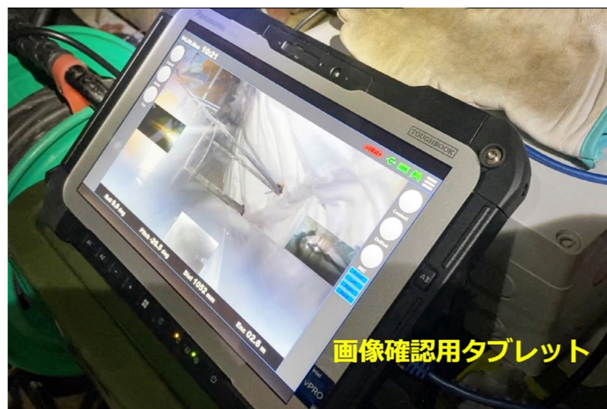
モニターでコンクリートの品質、地山と型枠の離隔（覆工巻厚）を確認
