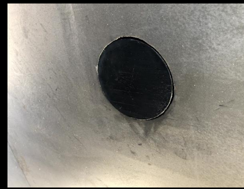
3、打設口閉(打設終了)
