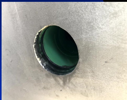
1、打設口開(打設前)
